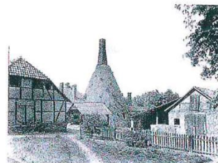
Rauchgaskegel der Glashütte Steinkrug. Bild: Forum Glas
